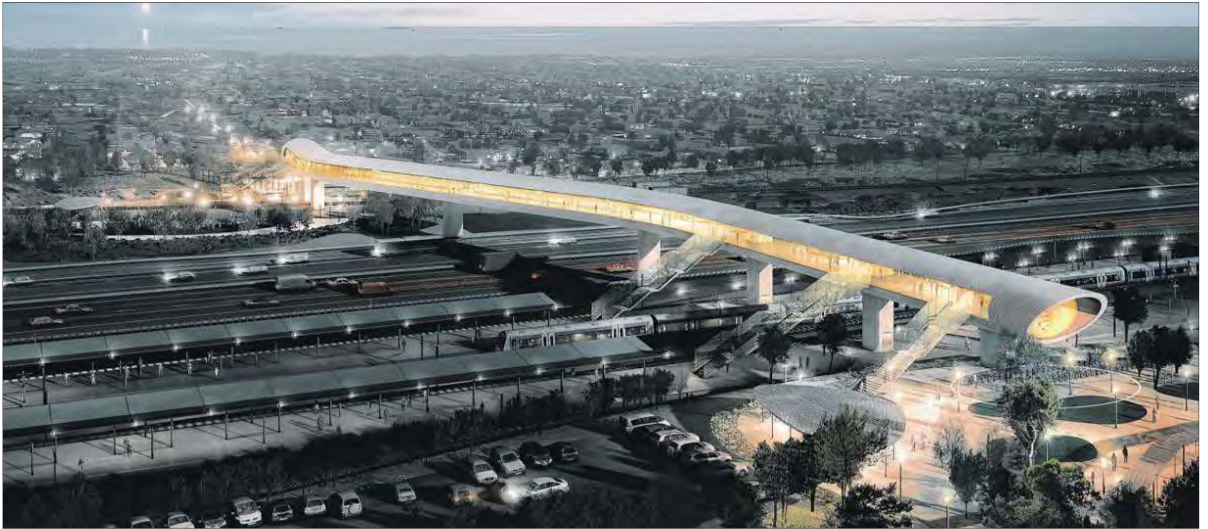
Ultramodern in die Zukunft: So soll der Bahnhof Køge nach dem Ausbau der Schienentrasse ausschauen. Die Überführung ist 240 Meter lang und verläuft in 14 Meter Höhe.
